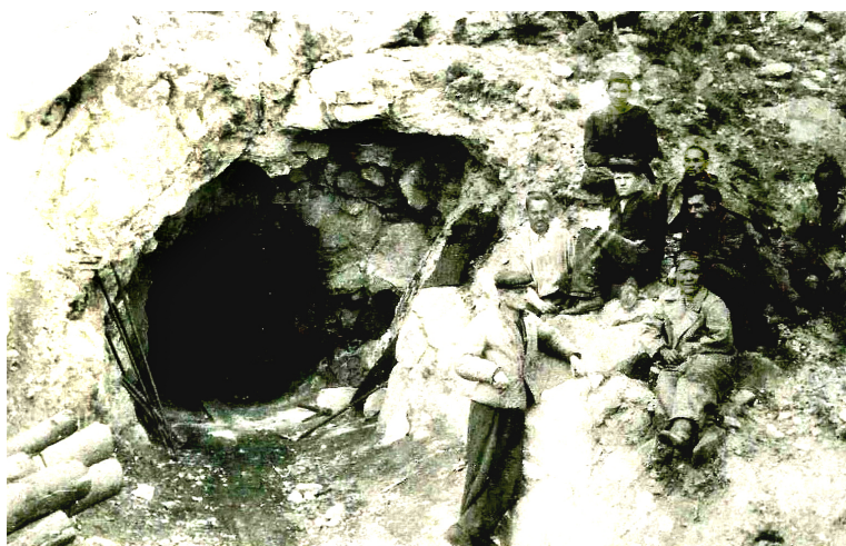
Одна из первых штолен Кан-и-Гутского рудника. Пророб и бригада рабочих. Слева видны бревна для крепей. 1950 г.
