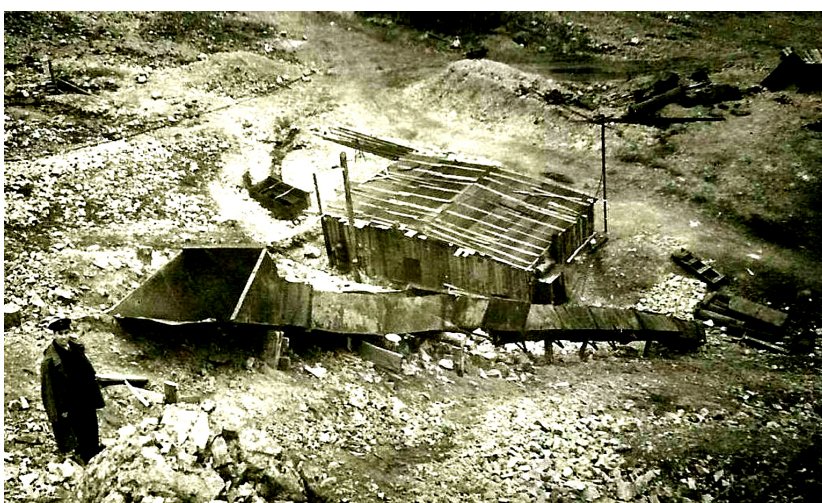
Камнедробилка возле отвала из штольни. Слева от нее три лотка для промывки проб. В левом углу – В.Н. Петров. 1950 г
