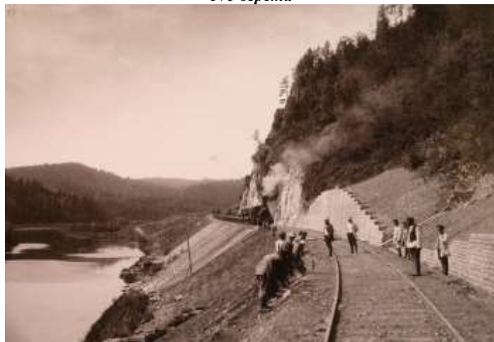
Рис. 6. Рабочие во время укладки железнодорожного полотна вдоль реки Сим
