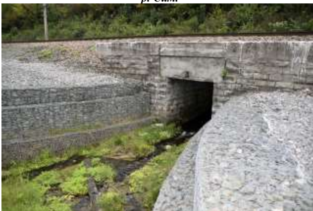
Рис. 11. Выход потока из тоннеля. Видны защитные габионные сооружения
