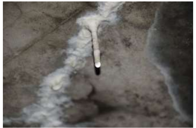
Рис. 10. Кальцитовые образования на потолке тоннеля
