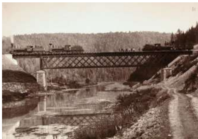
Рис. 4. Вид железнодорожного моста через реку Сим, 575 верста
