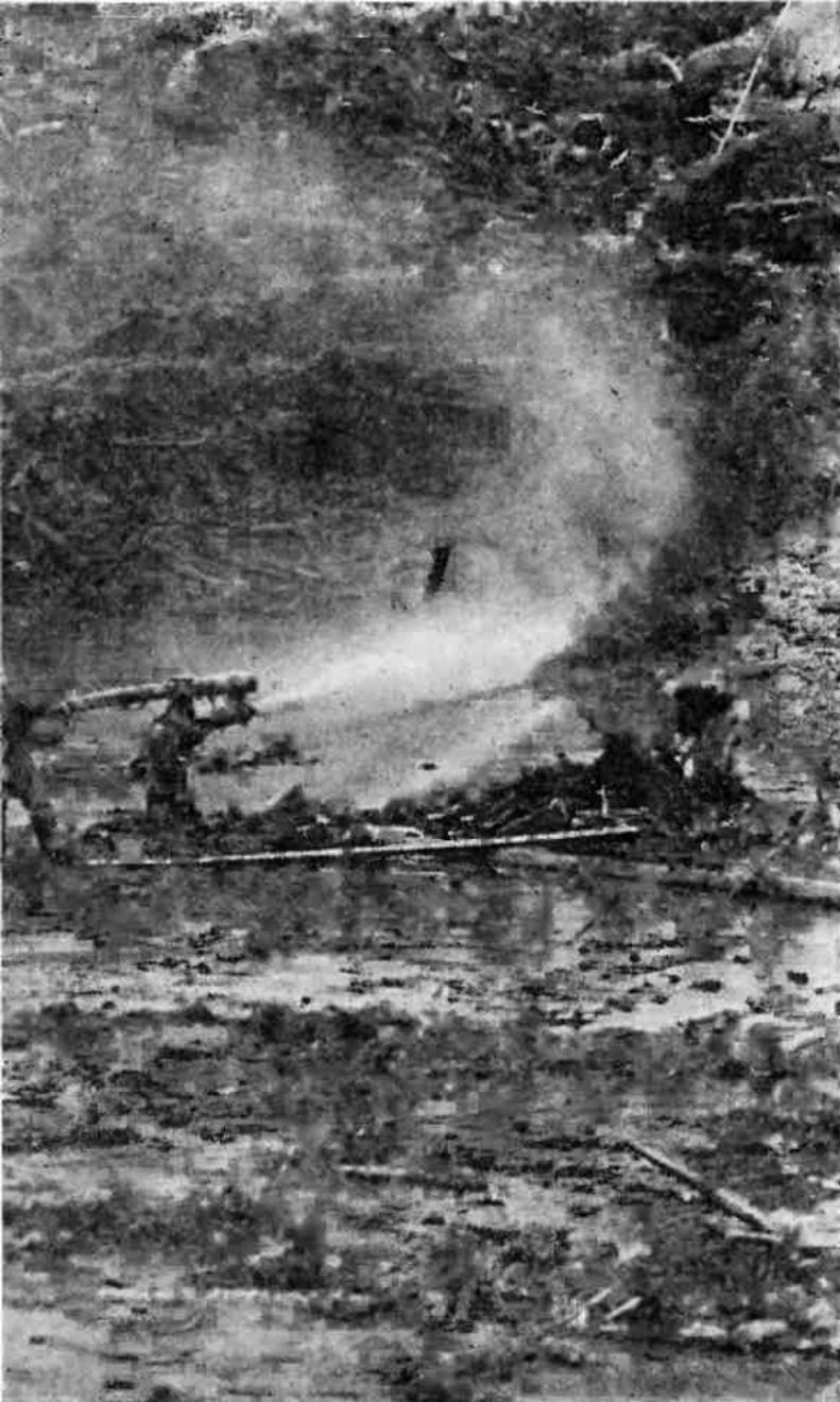
**ВОЛГО-БАЛТ.** Лопатой строил «Маринку» русский крепостной мужик. Самая современная техника помогла советскому человеку создать Волго-Балт. Экскаваторы, земснаряды, бульдозеры, скреперы прокладывали трассу канала. Под мощными выстрелами водяной пушки — гидромонитора — рушились земляные бастионы на водоразделе. Вода прокладывала путь воде.
