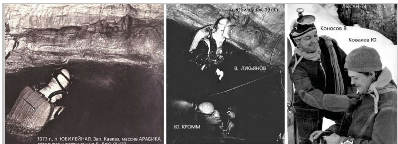
Рис. 9. Использование дыхательных аппаратов замкнутого цикла ИДА-64 с регенерацией дыхательной смеси и промышленных гидрокомбинезонов ГК-СВУ-Б (п. Юбилейная, п. Лысанская), 1973-1974 гг.
