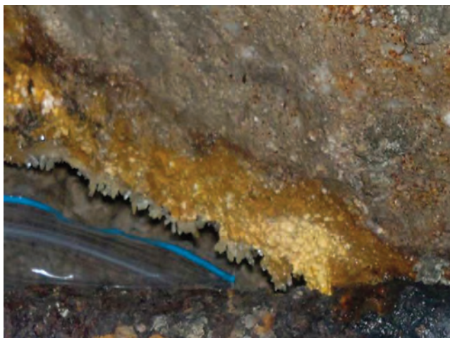
Рис. 13. Новообразованные кристаллы гипса и корка магнезиоферрита и ярозита, образовавшиеся на контакте гипс-ангидритовой породы подпорной стенки со стальной арматурой. Фото К. Худеньких.
