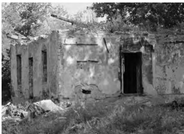
Рис. 3. Разрушение дома в результате активизации процесса карстообразования (Самарская область). Фото И.В. Ланцовой
