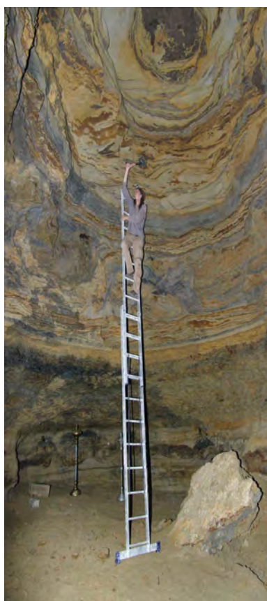
Работа по зачистке купола пещерного храма от обвалоопасной породы.
